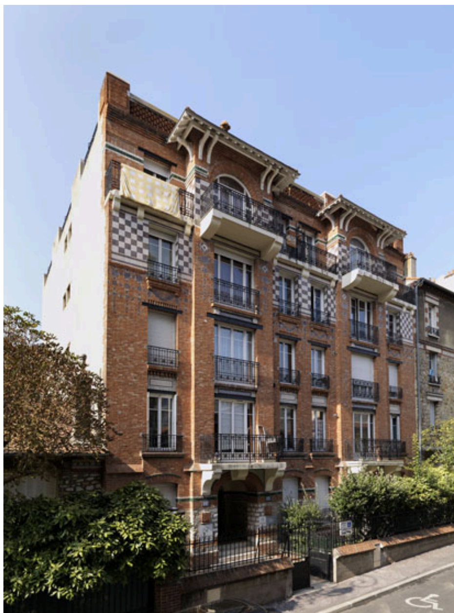
Vue d'ensemble de l'immeuble depuis la rue
