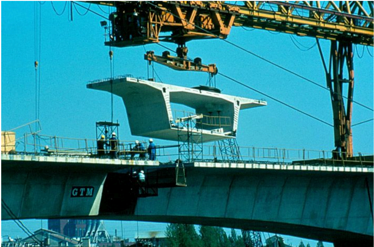
Choisy-le-Roi, Alfortville, Vitry-sur-Seine. Pont de Choisy de l'A86. Vue du chantier. Mise en place d'un voussoir encore suspendu à la grue. Photographie. (Ecole nationale des ponts et chaussées. 2 S 039)
