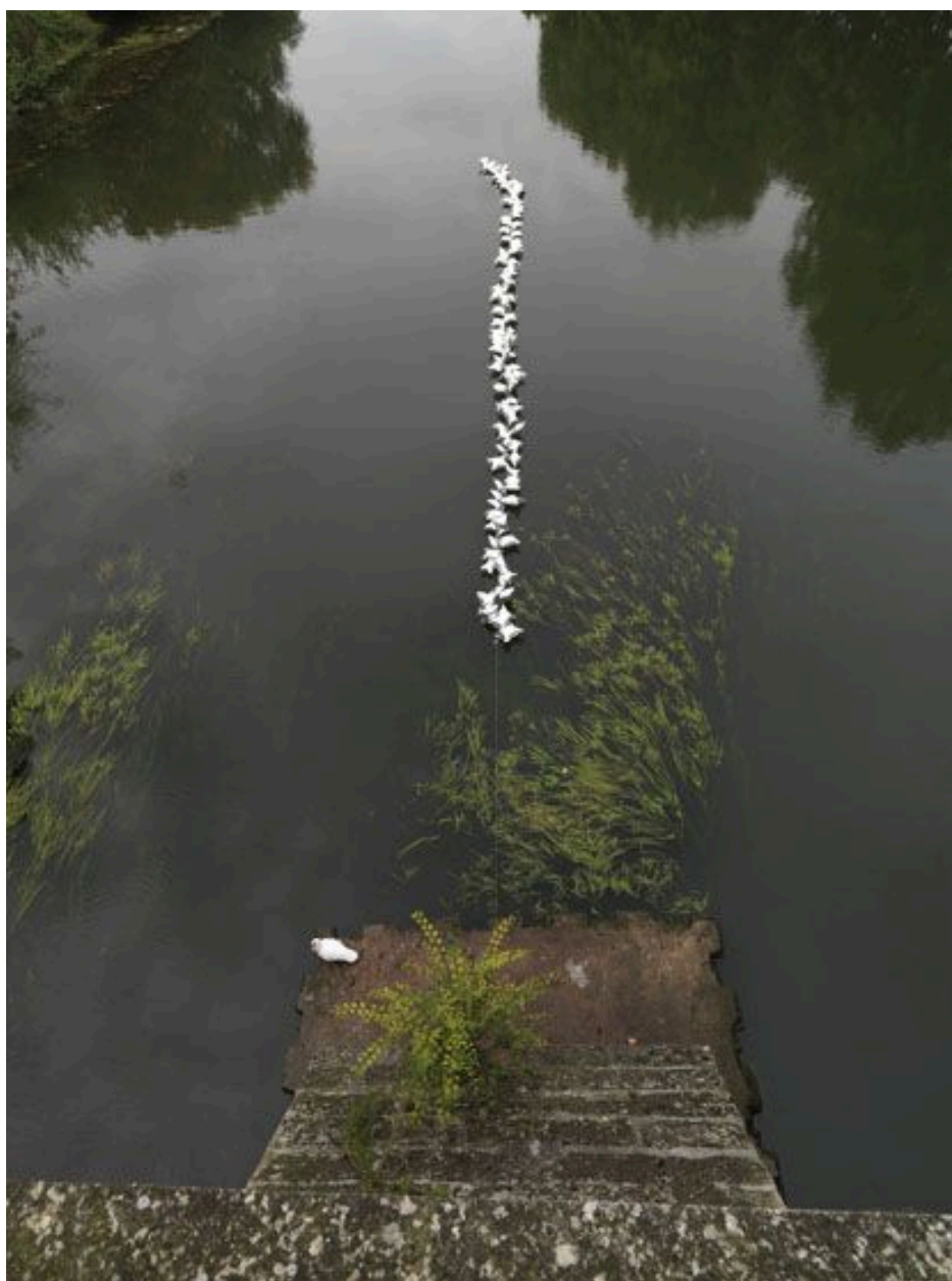
Crèche d'une pile vue depuis le pont vers l'aval.
