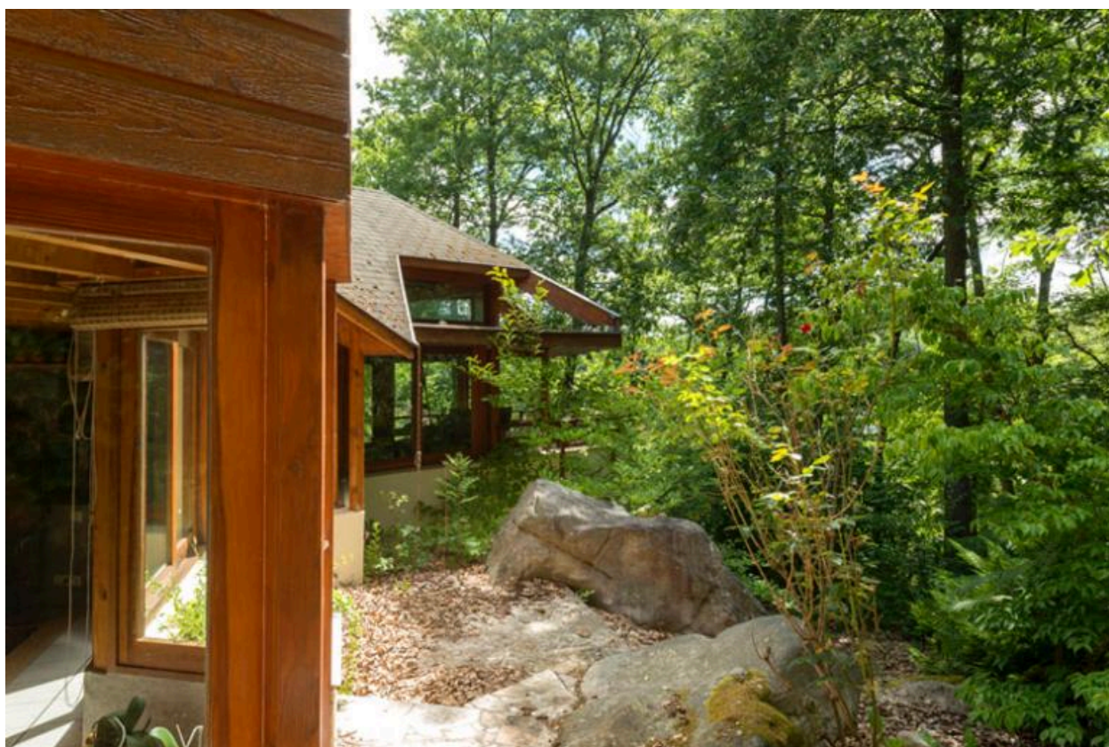
Vue partielle de la façade latérale : détail des avancées de la toiture.
