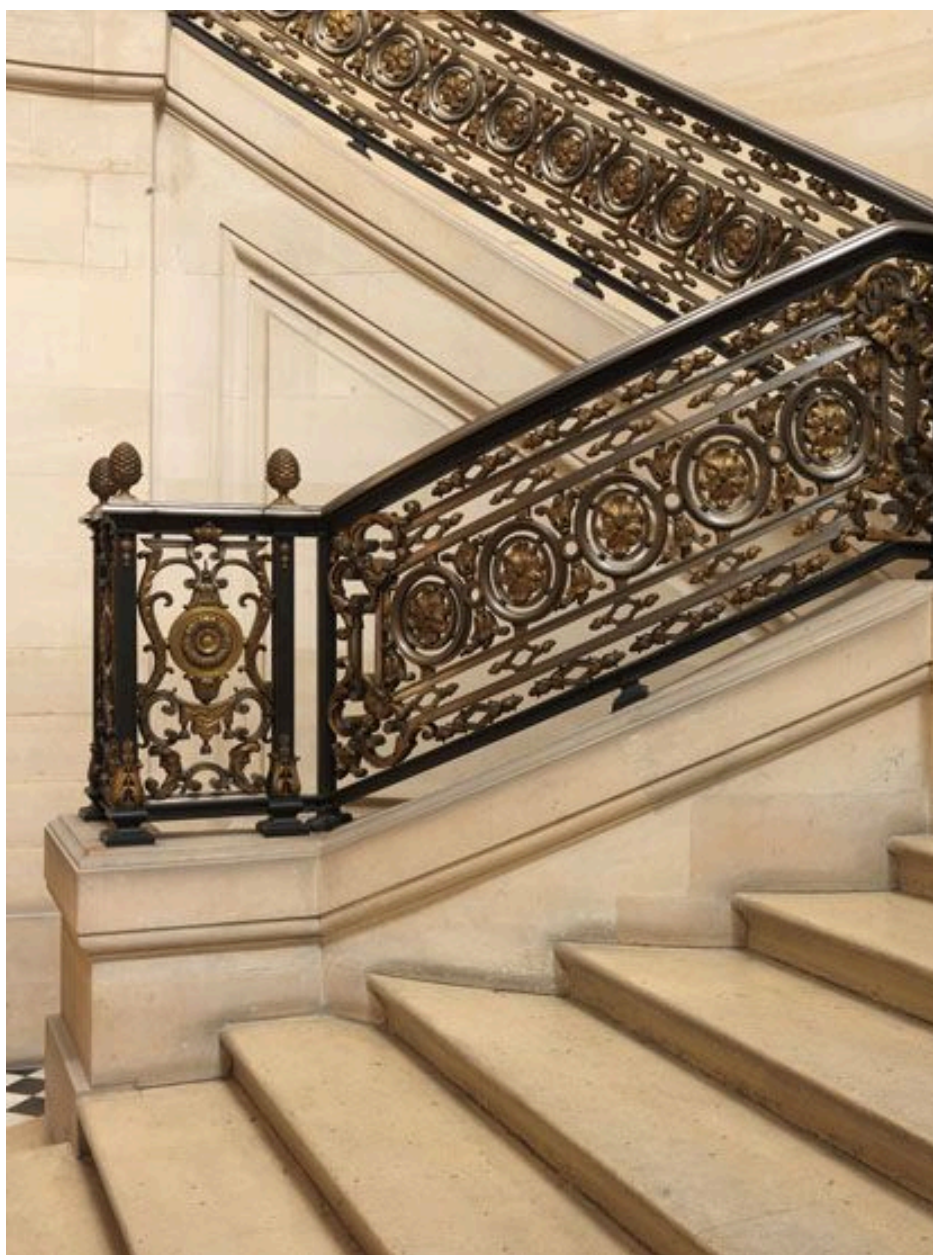
Gaine de départ et garde corps du départ central droit.
