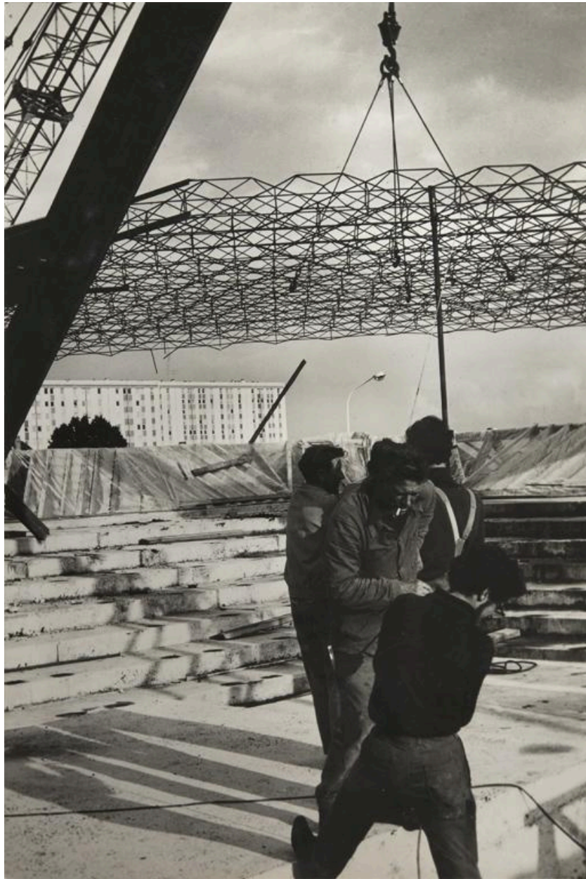
Vue du chantier, pose de la structure métallique de la toiture.
