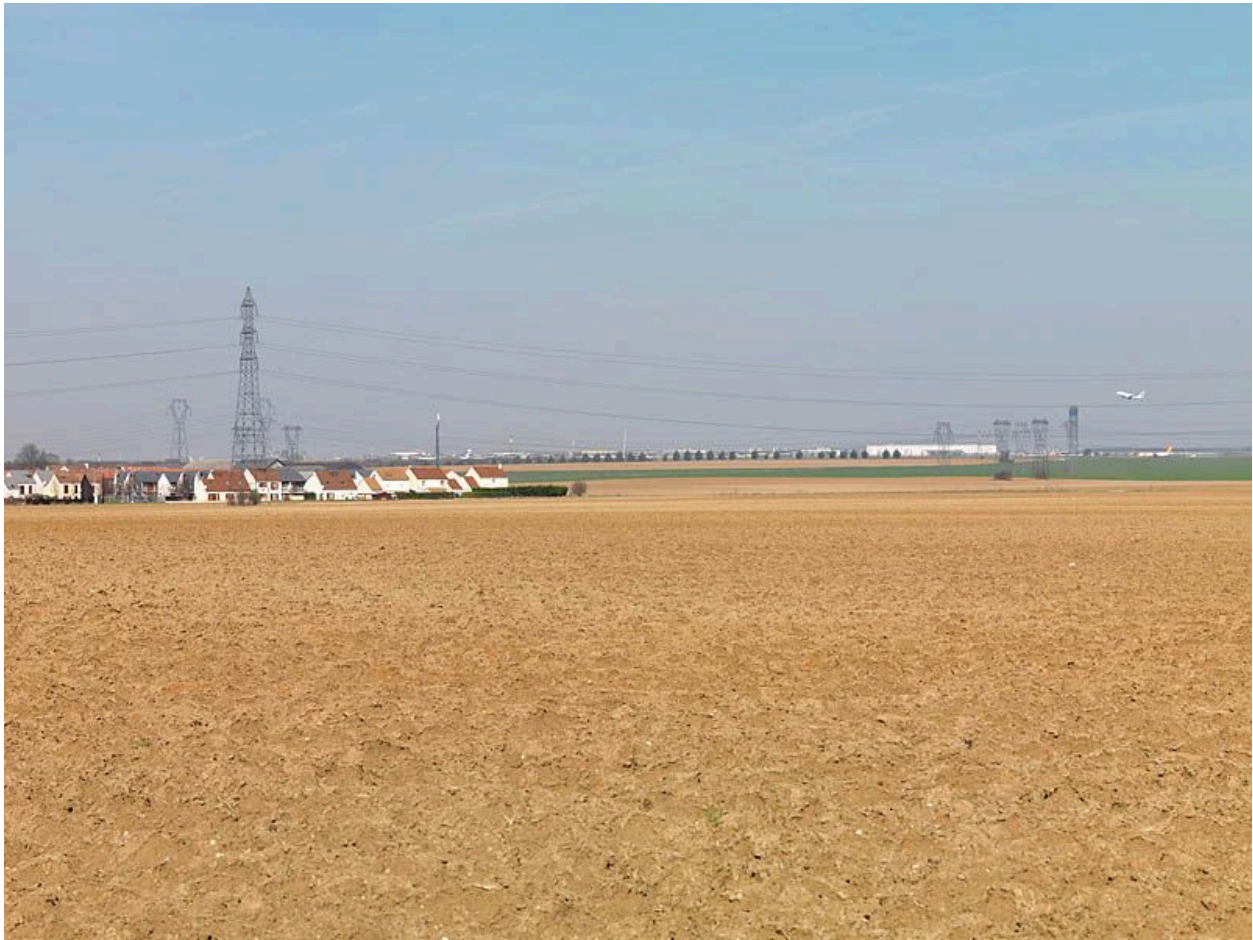
93, Tremblay-en-France. Champs, pavillons et aéroport.
