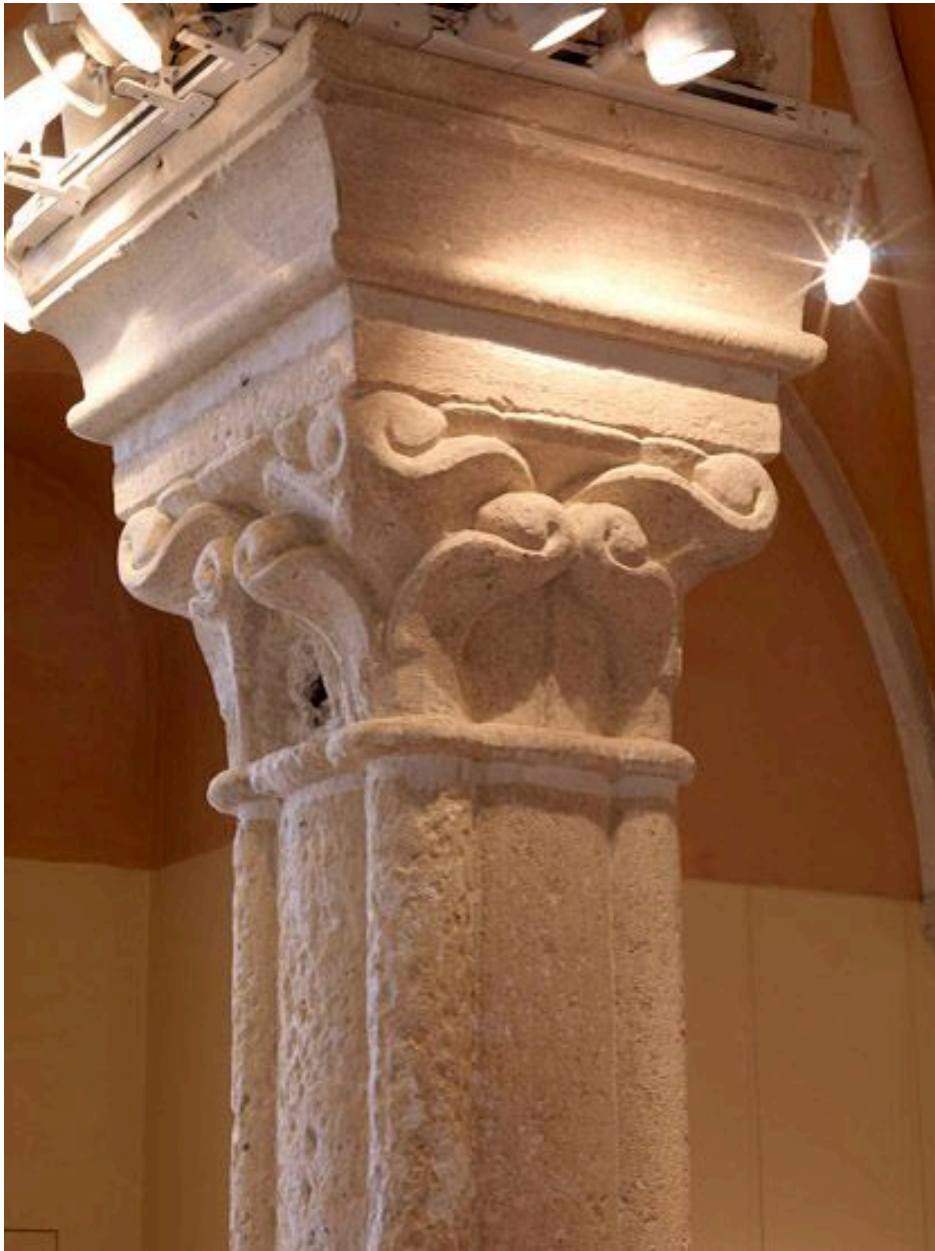
La salle basse occidentale : le chapiteau du premier pilier.
