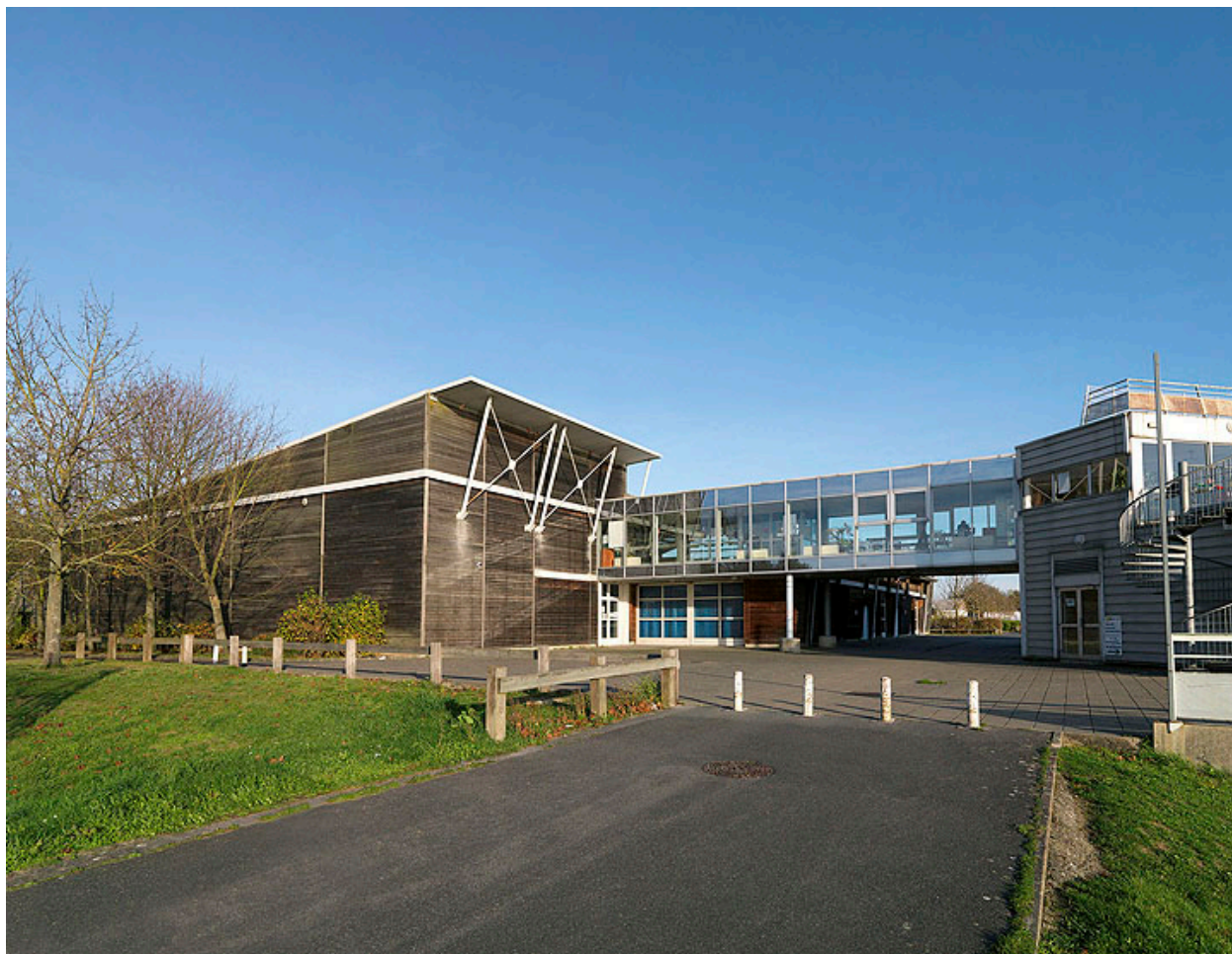
La passerelle de liaison entre le bâtiment de l'UCPA et les gymnases.
