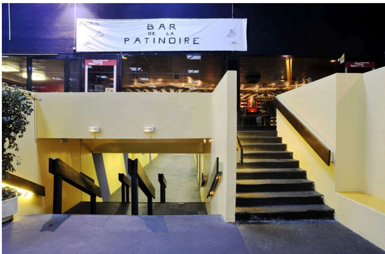
Escaliers d'accès à la patinoire, vue prise vers la sortie.
