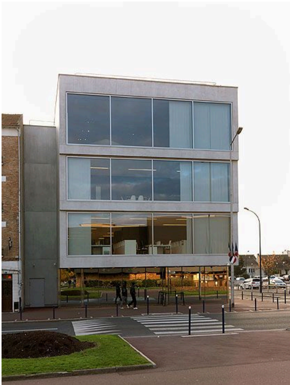
Façade principale du Mémorial de la Shoah, construit en 2008-2012 par Roger Diener, avenue Jean-Jaurès.
