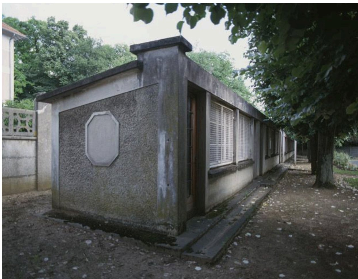
Cure d'air fermée, le long du mur de clôture, à l'ouest (secteur Léon-Jouhaux).
