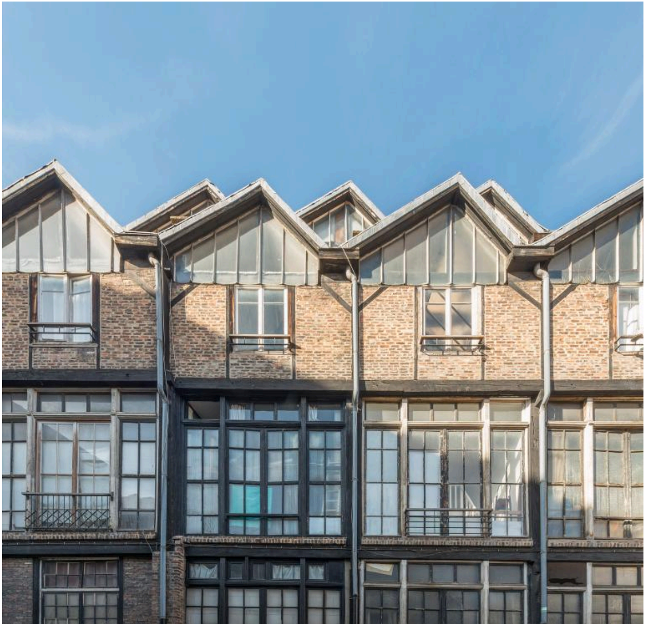
Vue de la façade du bâtiment d'ateliers dit "bâtiment Fernand Léger" donnant sur jardin
