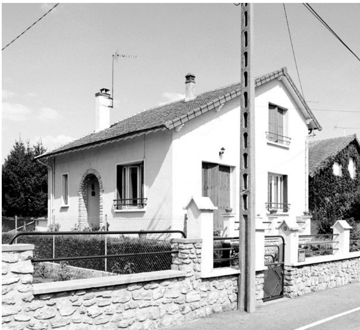
Pavillon au n°20 rue des Castors : vue d'ensemble.
