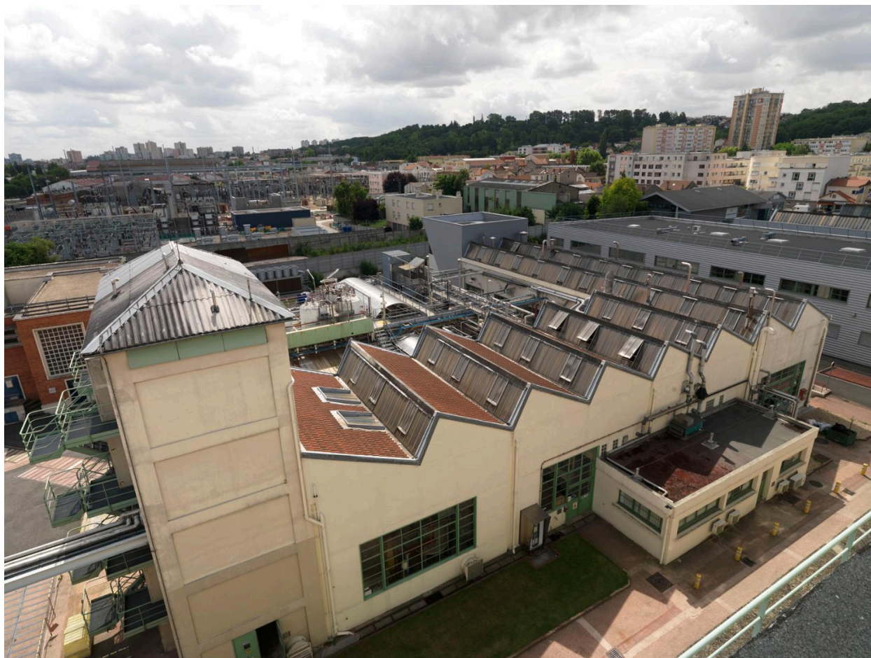
Site Sanofi. Vue des toits en shed.
