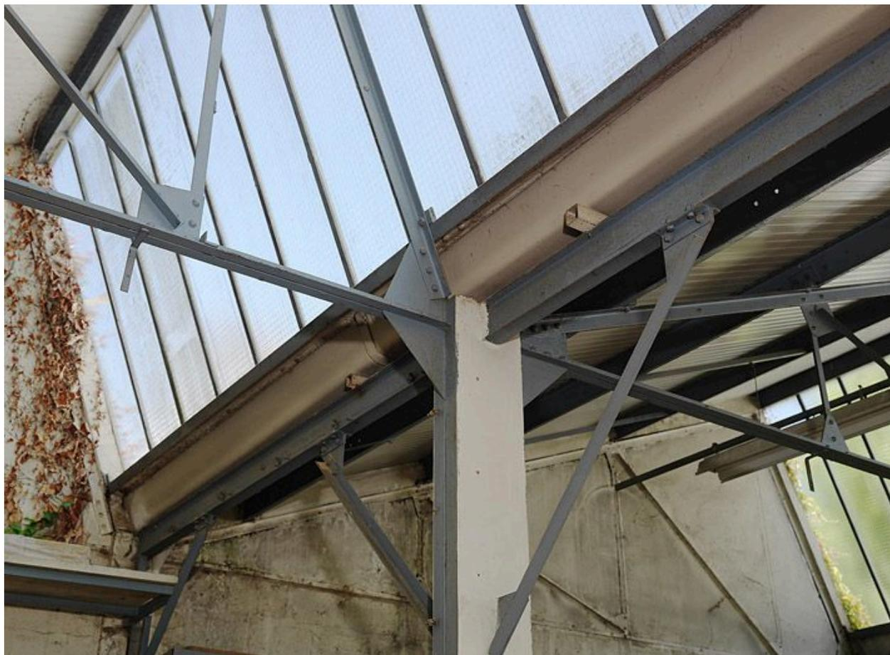
Atelier de fabrication, détail de la couverture en shed.
