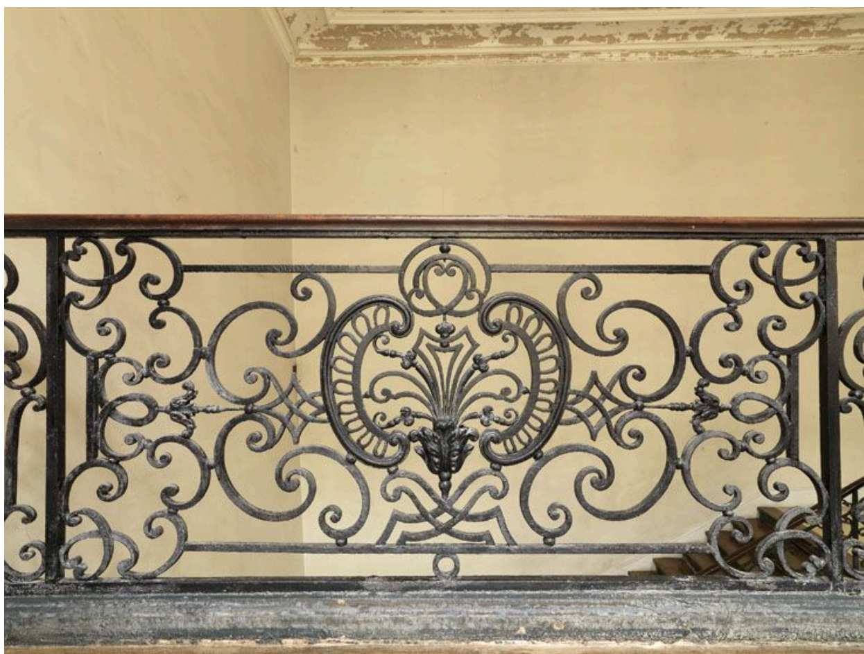
Escalier principal : le panneau droit du dernier palier, détail.
