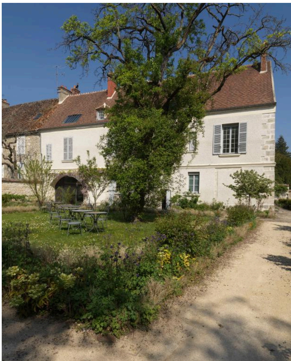
Vue de la façade postérieur du bâtiment principal (5)
