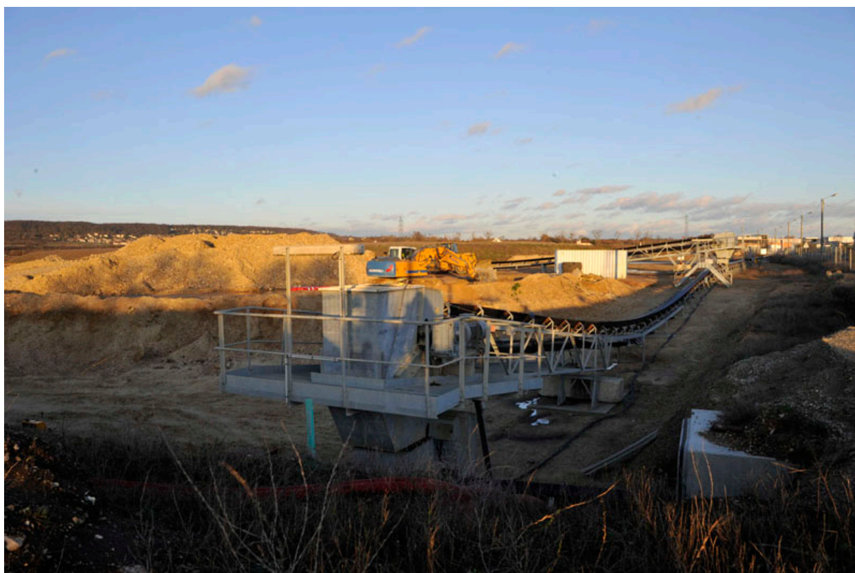
Triel-sur-Seine, carrière (sablère et gravière) Lafarge Granulats, 2 chemin des Graviers. Carrière, bandes transporteuses.
