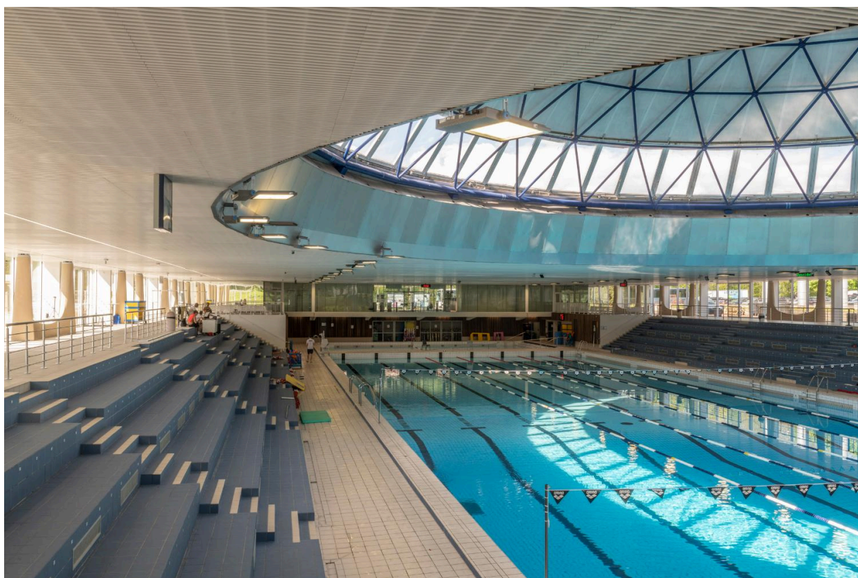
Bassin olympique, gradin et dôme, vue intérieure depuis le sud
