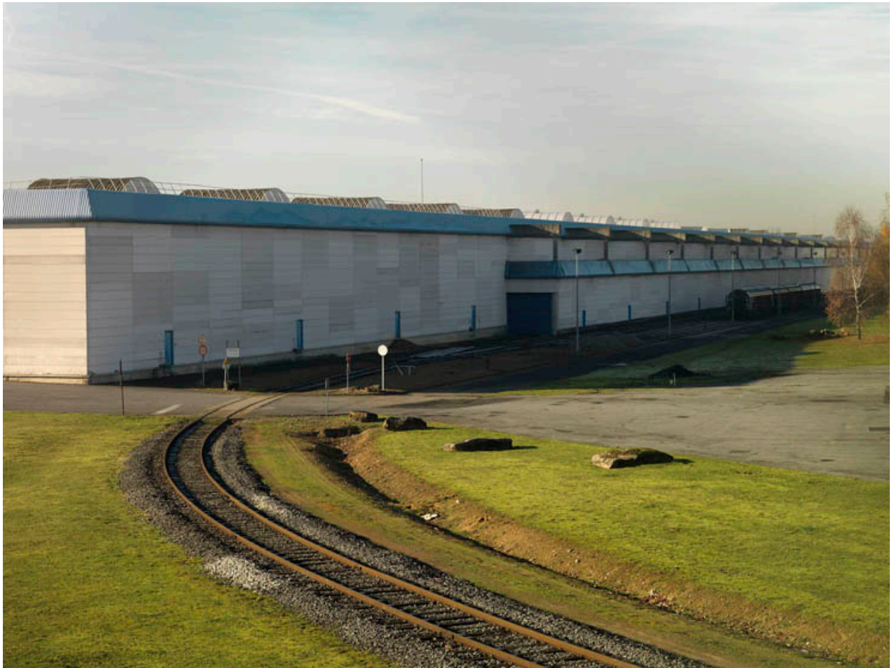
Survilliers. ZI de la Porte des Champs. Etablissements Electrolux.
