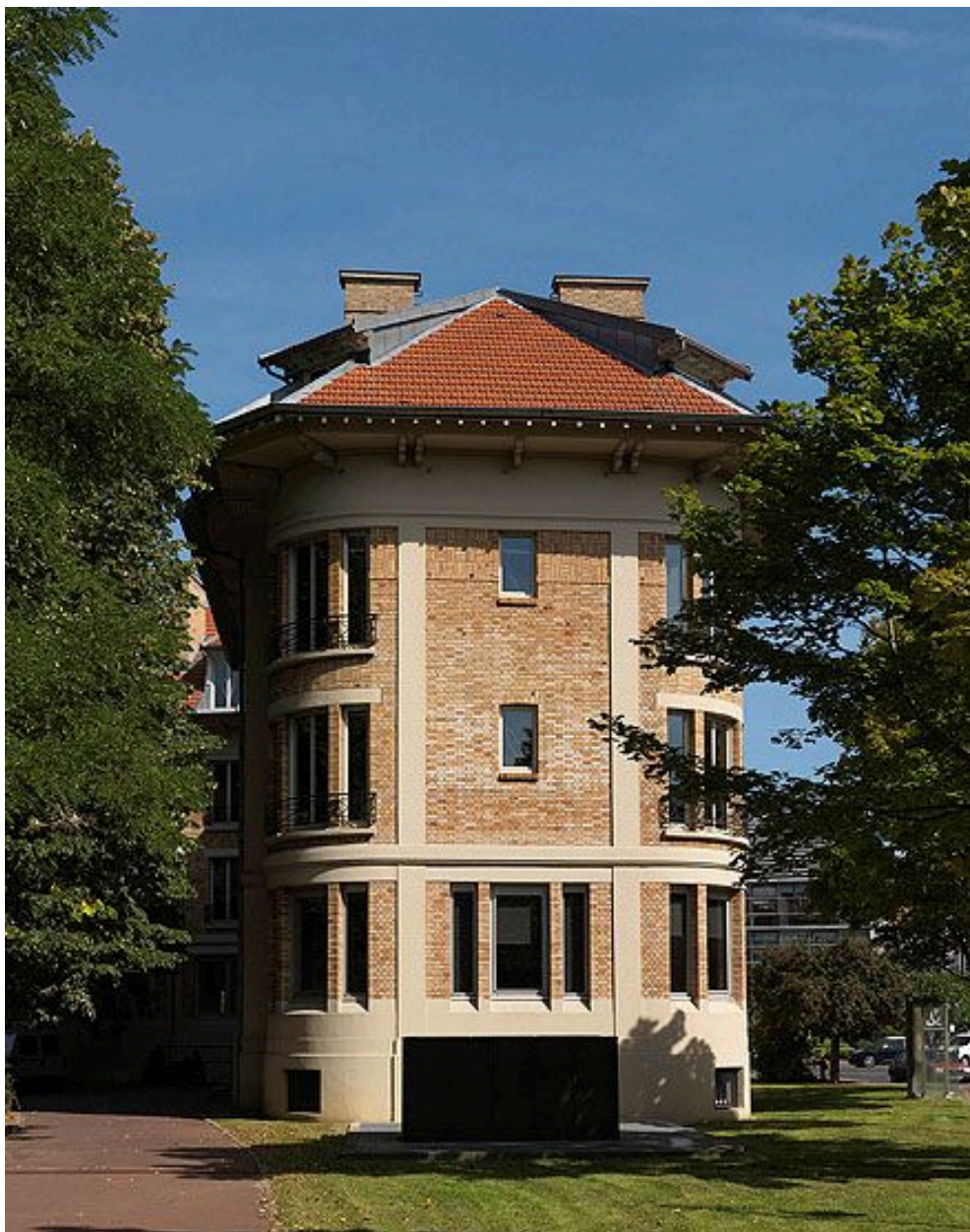
93, Saint-Denis, immeuble de logements de la Compagnie des Entrepôts et Magasins généraux, 50 avenue Président-Wilson. Vue d'ensemble de l'immeuble.
