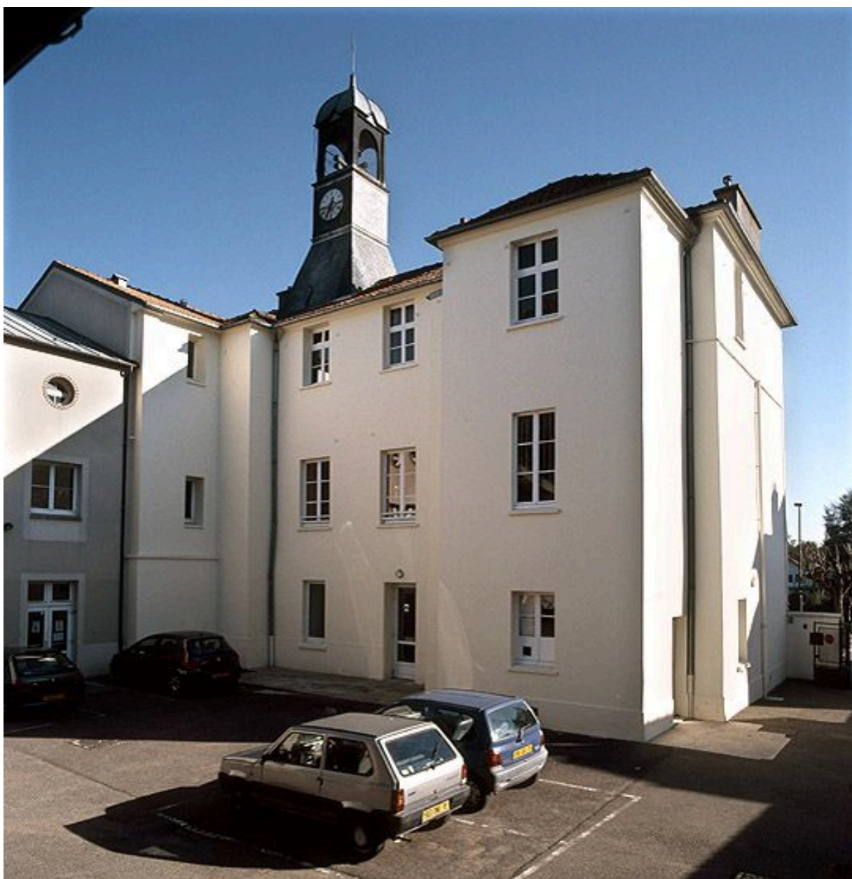
Façade arrière et latérale.
