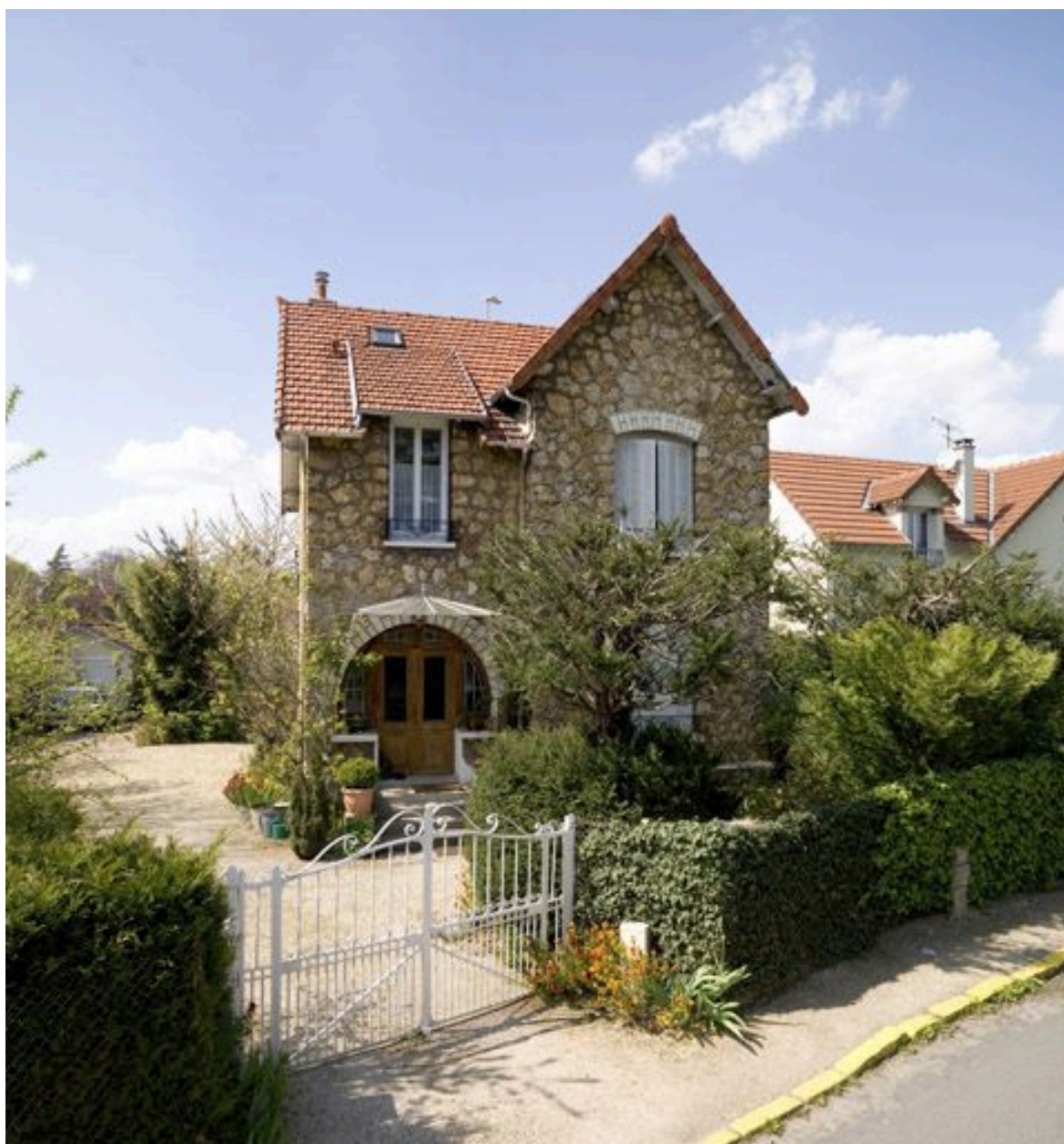
Vue d'ensemble du pavillon, 42 allée des Vergers.
