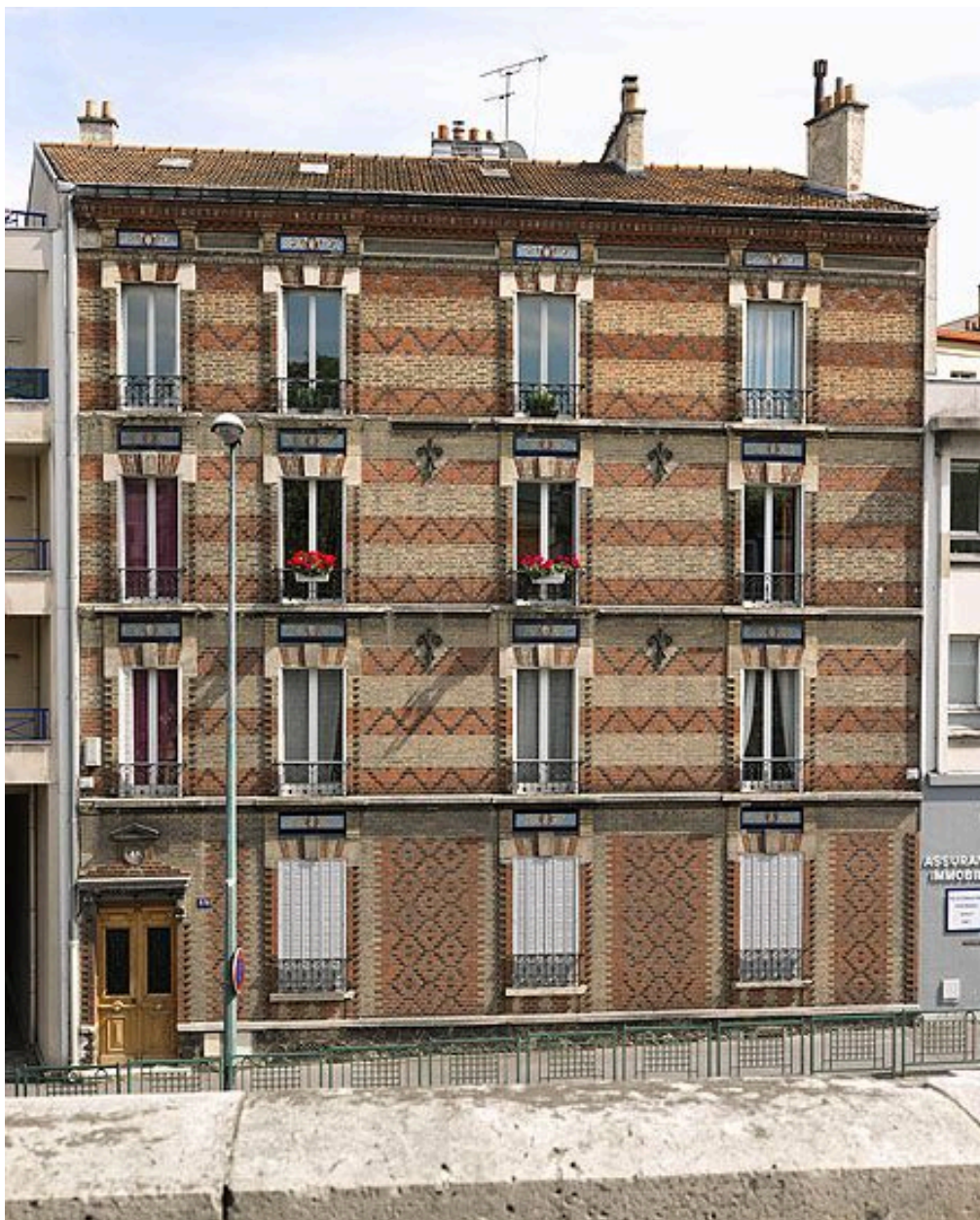
92, Suresnes, immeuble, 49 boulevard Henri-Sellier. Façade antérieure de brique polychrome.
