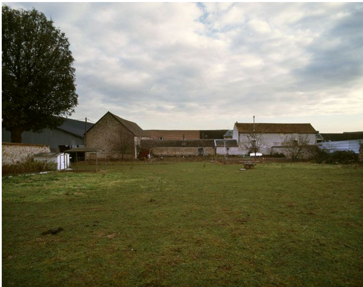
La façade arrière des bâtiments situés à l'ouest de la cour.
