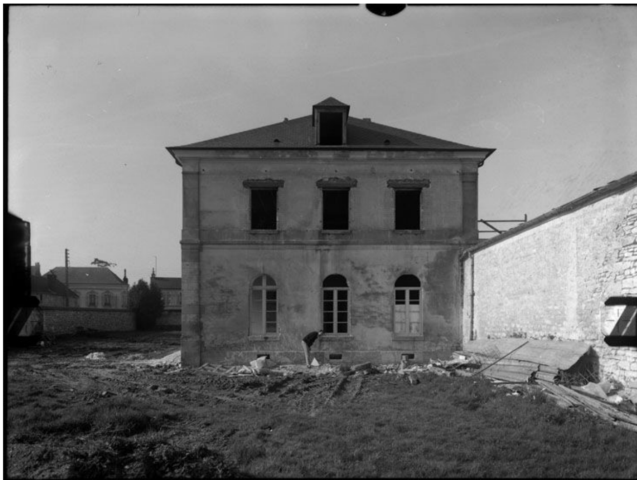
Pavillon en cours de restauration.
