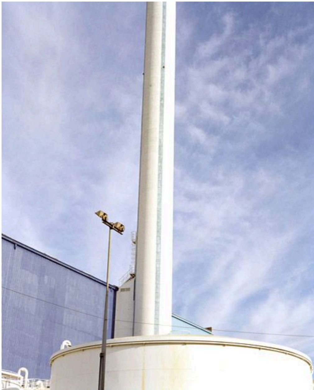
Ivry-sur-Seine, centrale thermique dite Electricité de la Seine, puis EDF, quai Auguste-des-Haies . Détail de la cheminée.
