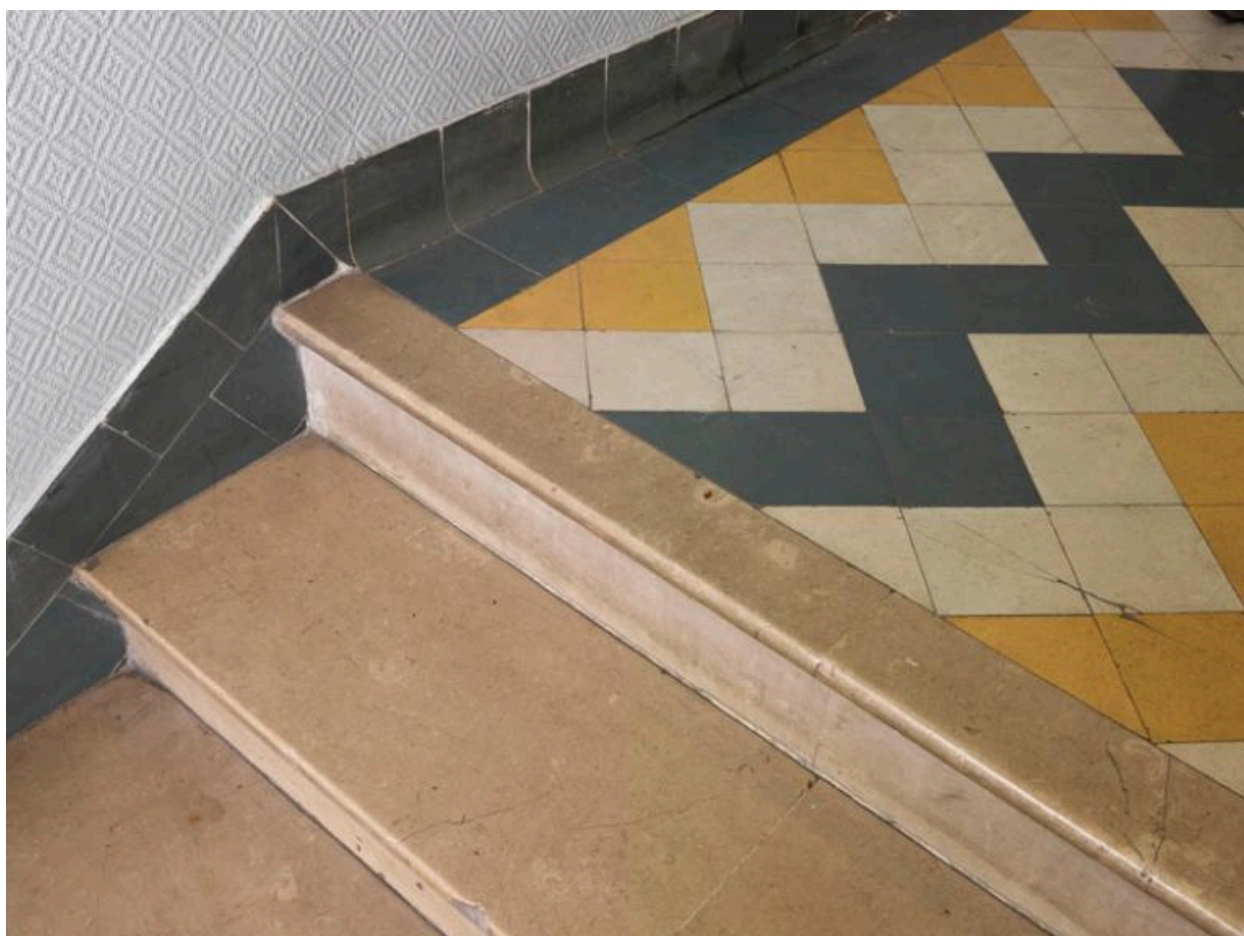
Carrelage du sol de l'entrée des logements.
