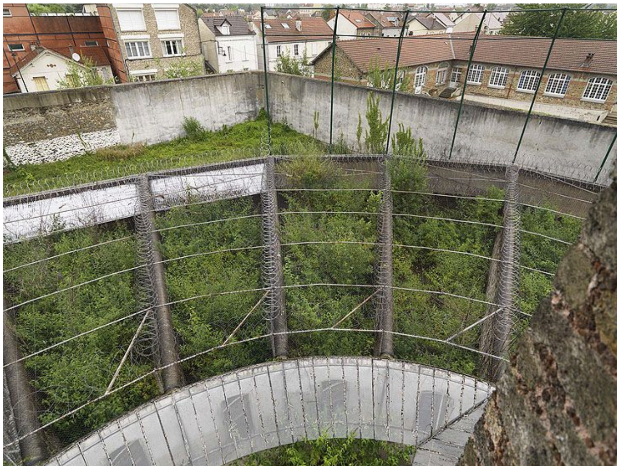
Les cours de promenade, vues depuis le haut (côté nord-est).
