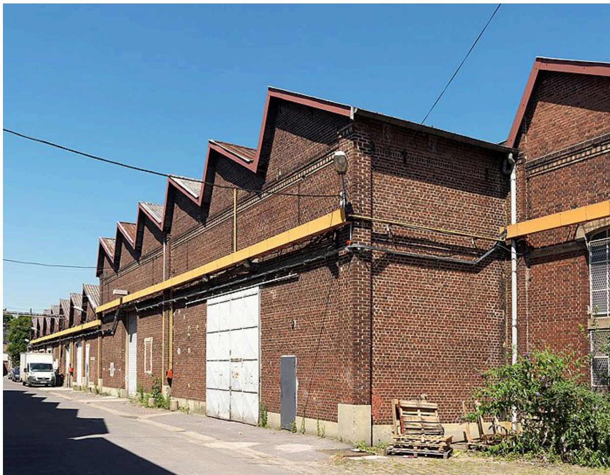
93, Stains, fonderie des poudres et grenailles, 47 rue Jean-Pierre-Timbaud . Vue perspective des pignons des bâtiments.
