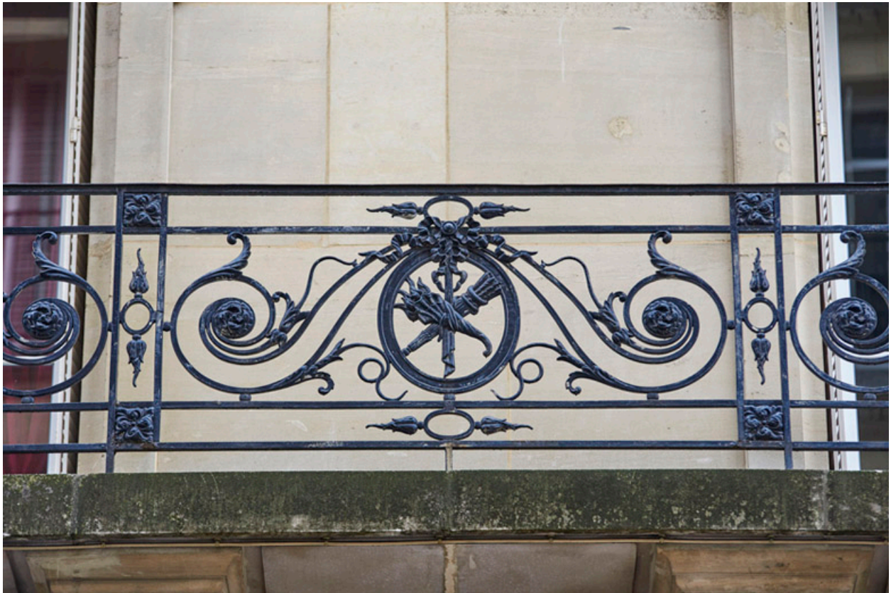
Vue du détail du balcon du 1er étage, rue Ernest Cresson.
