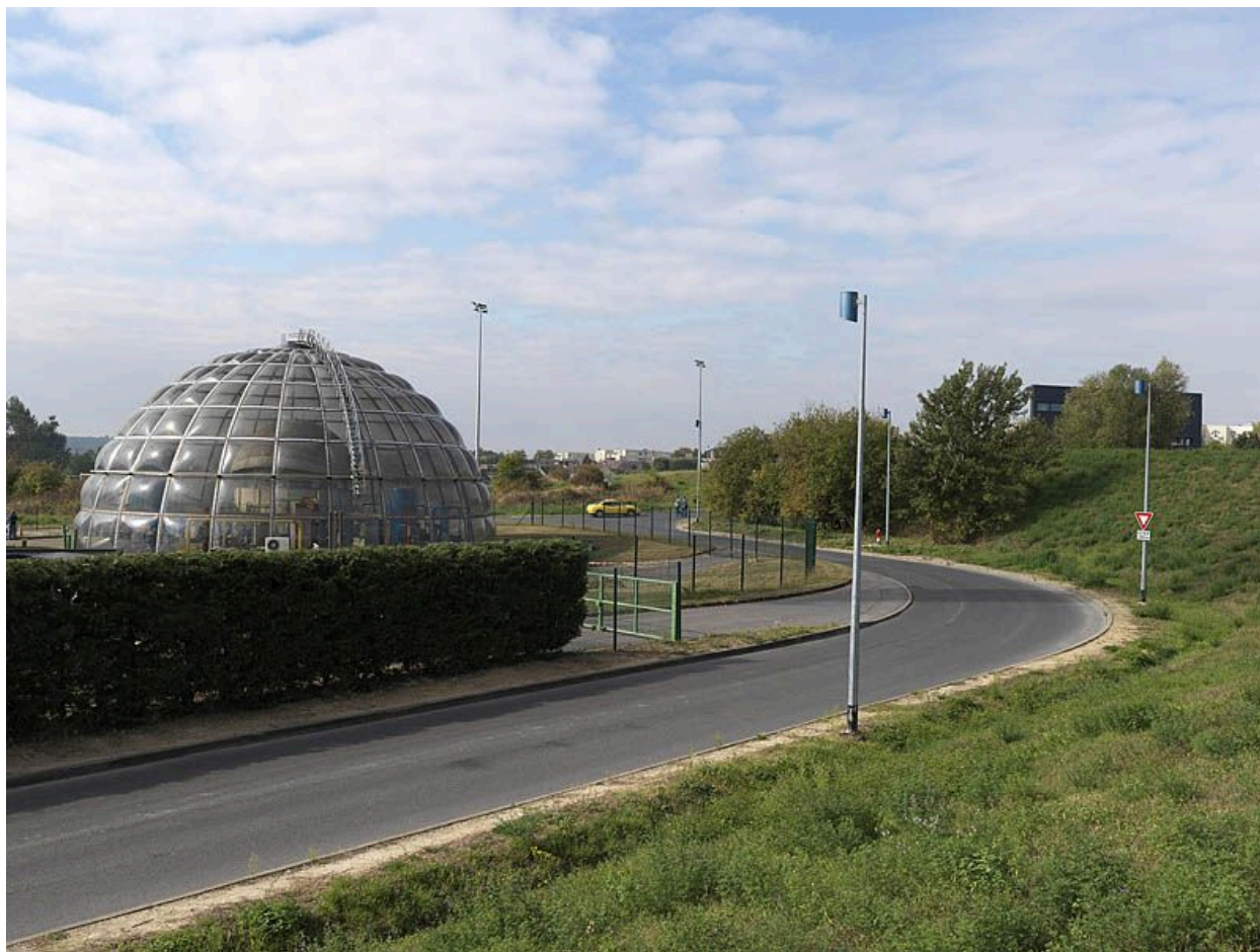
Vue de la petite coupole de 15 m ayant fonction de salle de contrôle.
