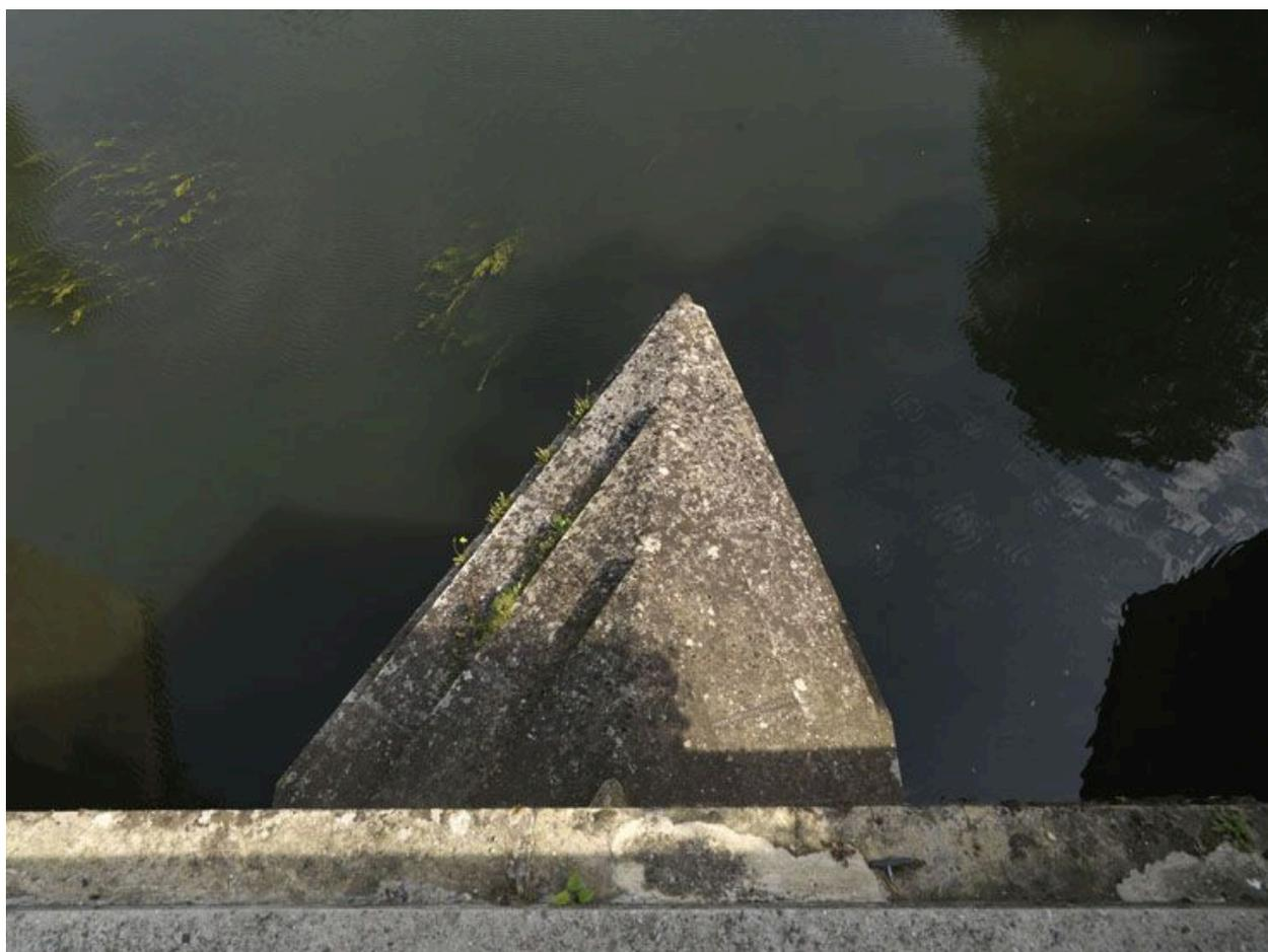
Partie supérieure d'une pile en éperon vue depuis le pont vers l'amont.
