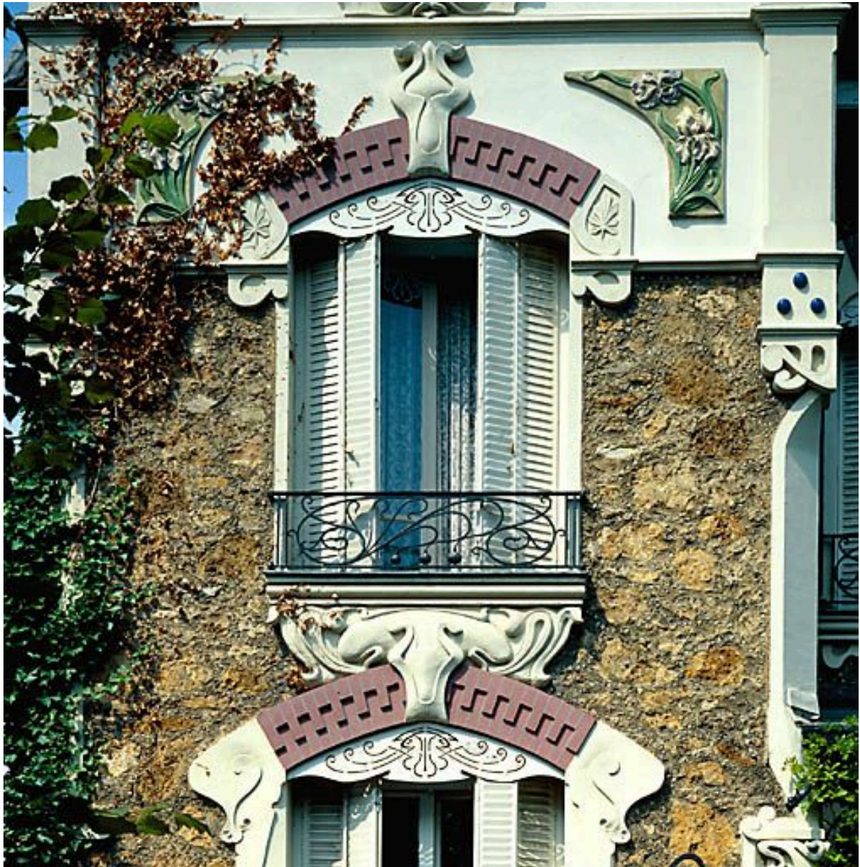
Vue partielle de la façade antérieure.
