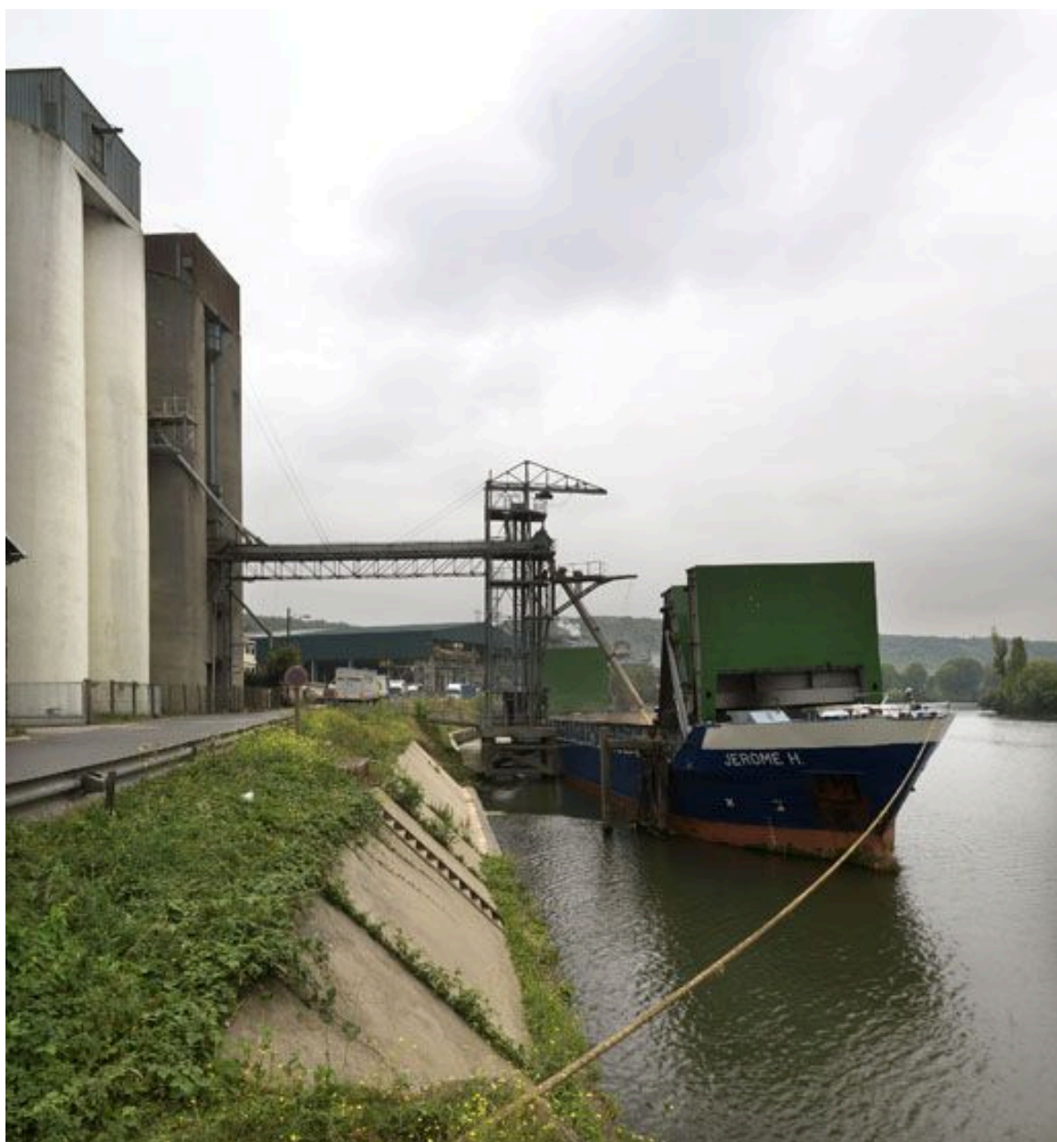
Bonnières-sur-Seine, silos de la Société anonyme des silos de Bonnières, quai de Seine. Chargement d'une péniche.
