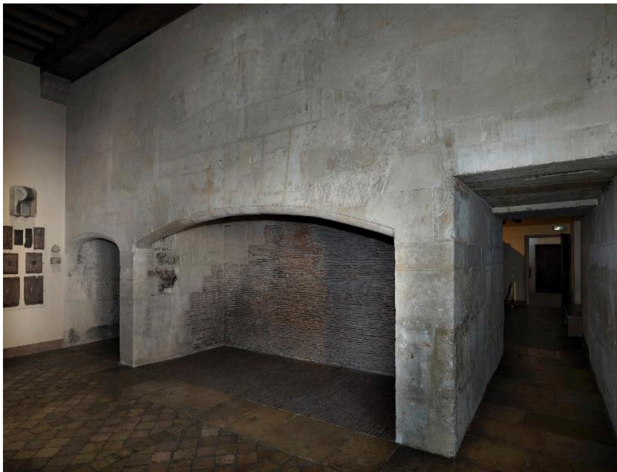
Cheminée de la salle des cuisines, au rez-de-chaussée de l'aile sud.
