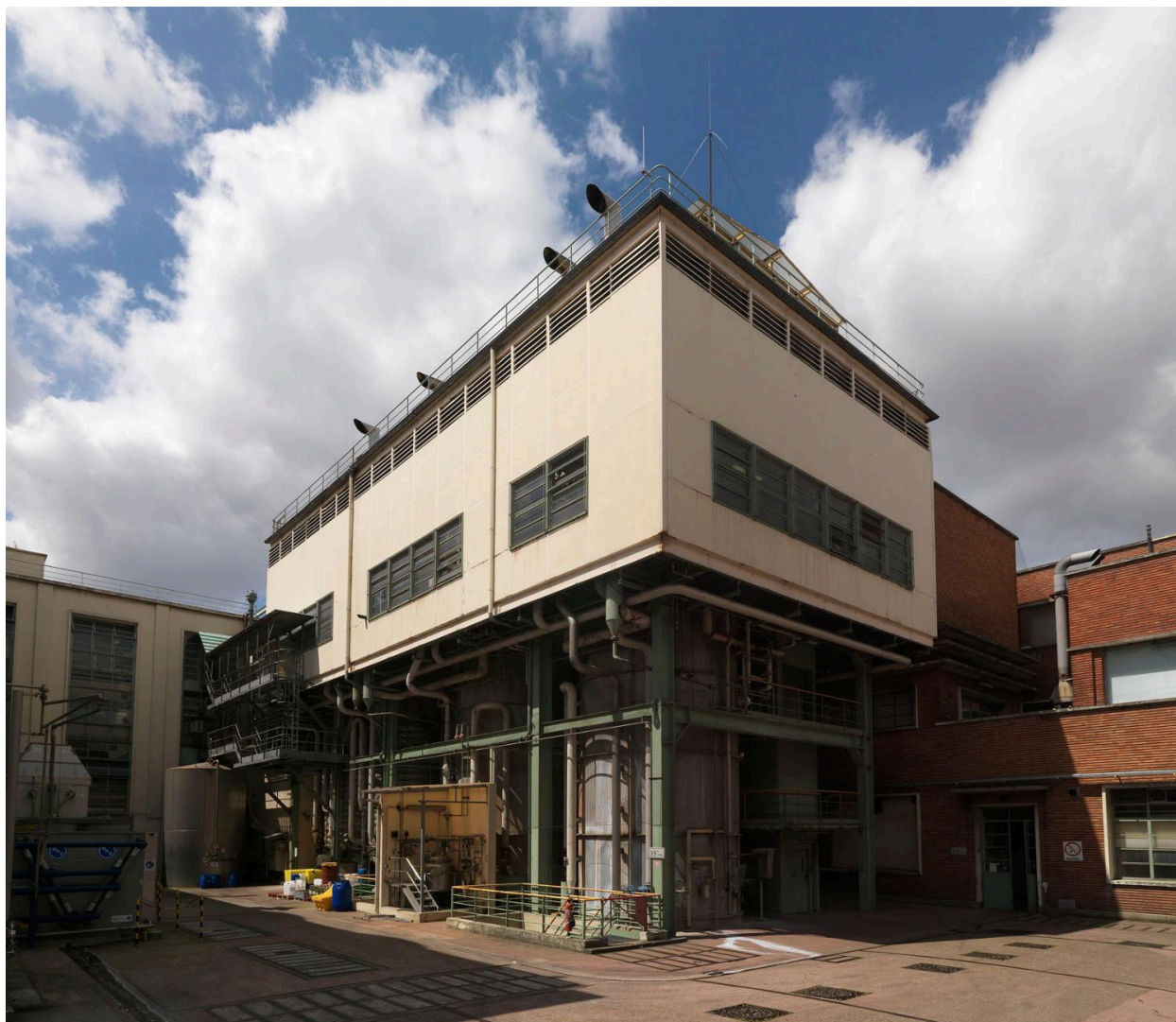
Site Sanofi. Vue d'un bâtiment de transformation.
