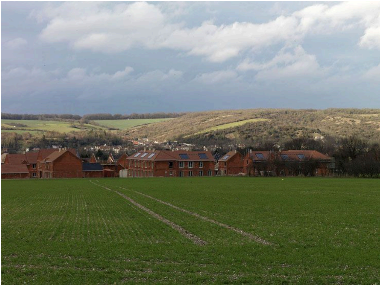
Freneuse : lotissement en construction.
