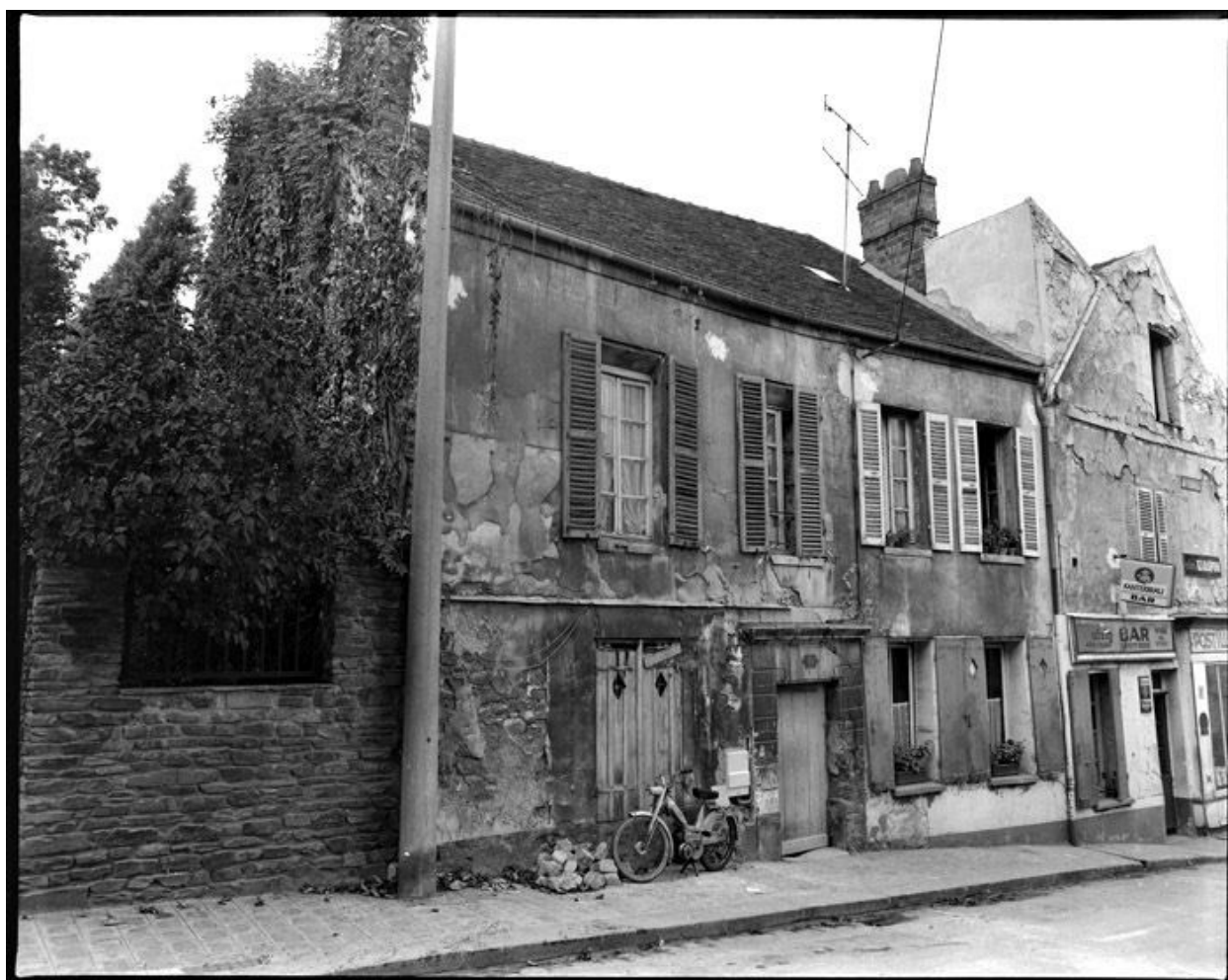
Maison, Sangle (rue de la) 10. Façade sur rue de la maison.
