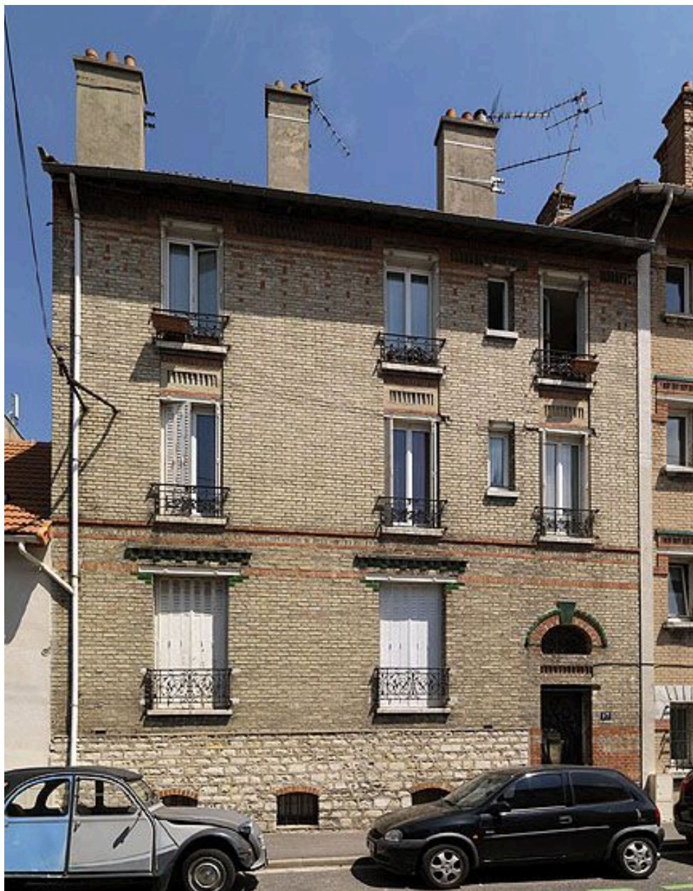
94, Arcueil, immeuble, 17 rue de Guy-de-Gouyon-du-Verger. Elévation de la façade sur la rue.
