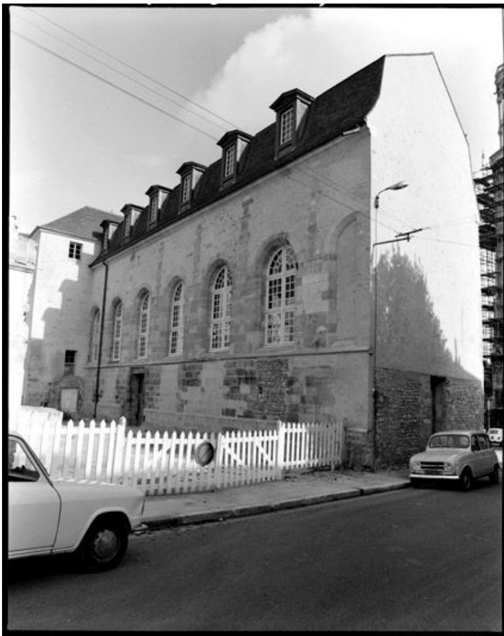
Ancien hôtel-Dieu, actuellement musée. Façade arrière de l'ancienne chapelle.
