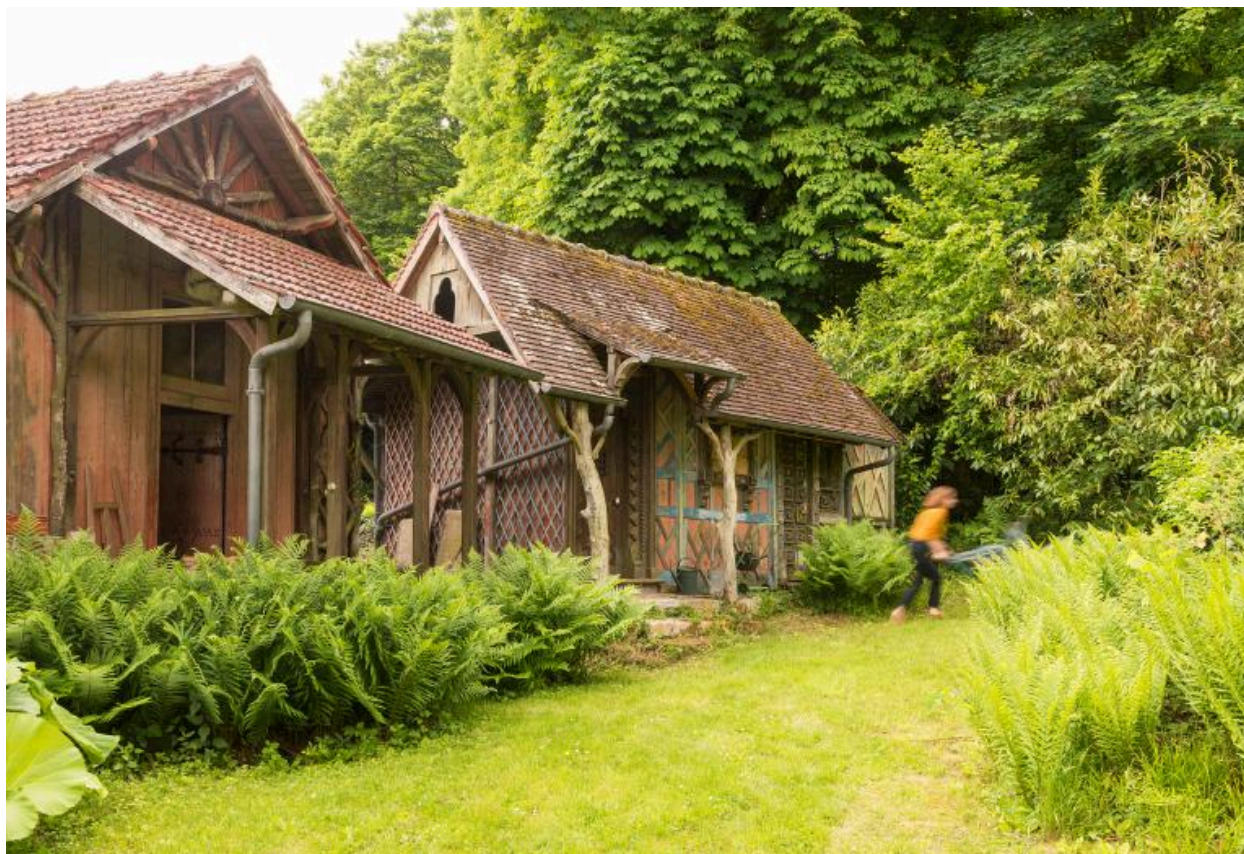
Vue des façades principales des ateliers (1)
