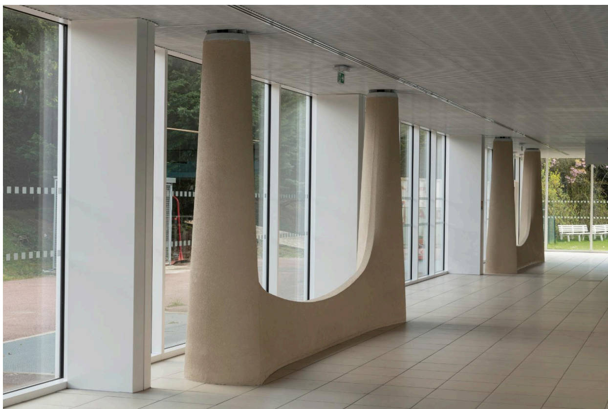
Vue intérieure du mur-rideau et de deux piliers en anse de panier inversé
