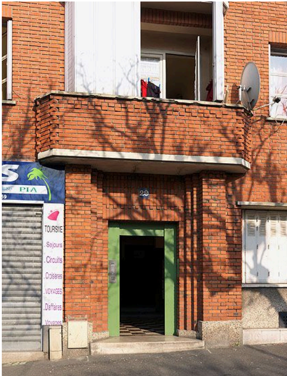
93, Pré-Saint-Gervais (Le), cité-jardin, avenue Jean-Jaurès. Détail d'une entrée de l'un des immeubles.
