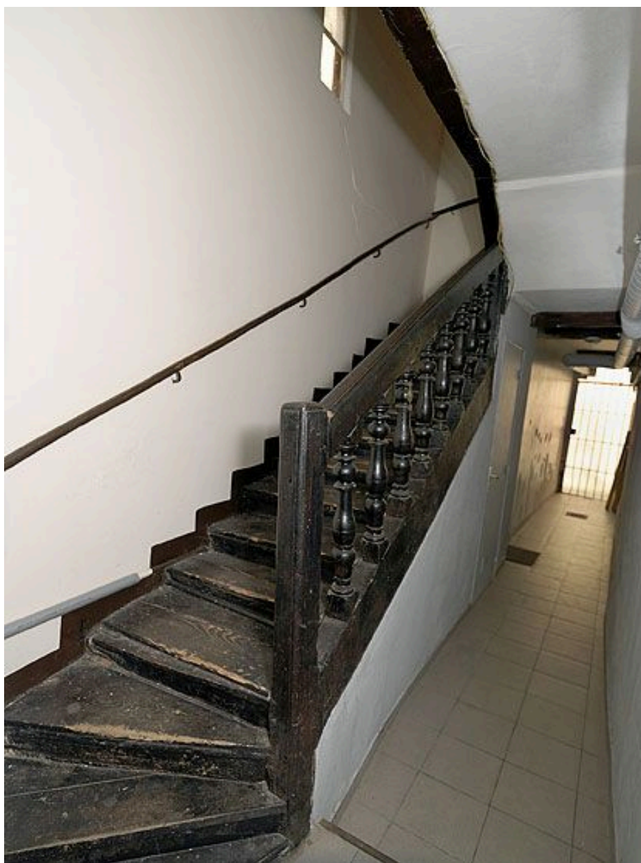
Maison ancienne au 46, rue Saint-Remy. Escalier à balustres tournés, en fond d'allée, 17e ou 18e siècle.
