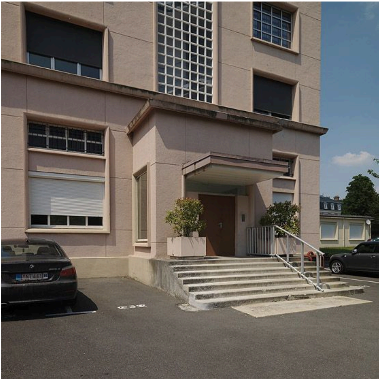
Entrée sud de l'extension PIC.
