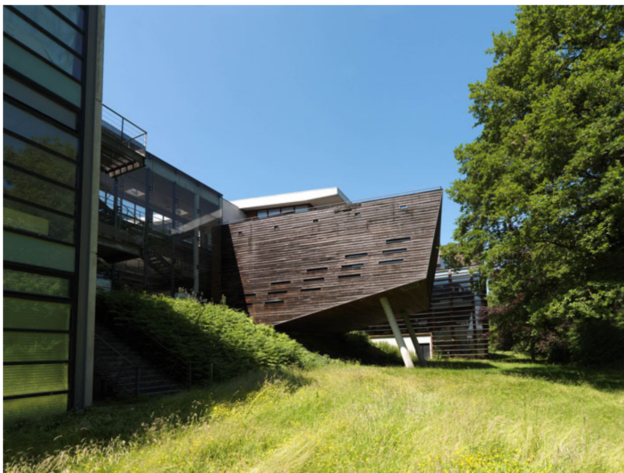
Bâtiment Bois de l'Etang, vue de la façade orientale vers le Bois de l'Etang.
