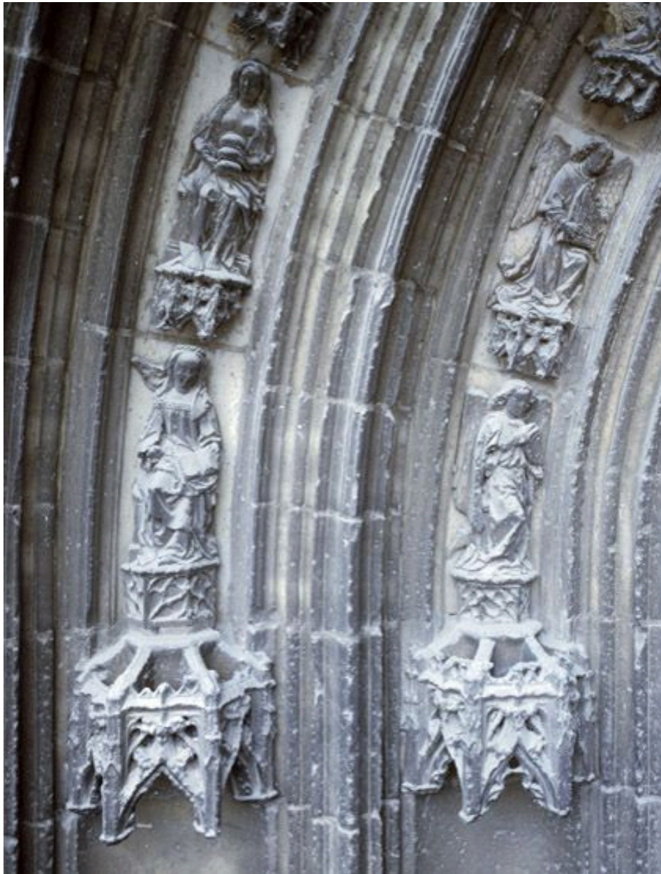
Les sculptures du portail Saint-Jean-Baptiste, vues depuis l'échafaudage dressé pour la restauration de la base de la tour nord (2008) : détail des voussures (à gauche du portail).
