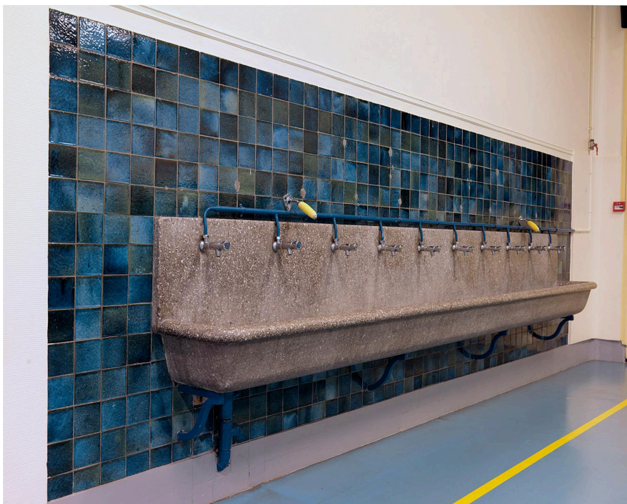
Vue des lavados des toilettes, carreaux de grès flammés.
